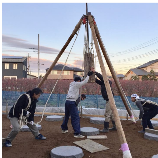
石場建て よいとまけ作業
